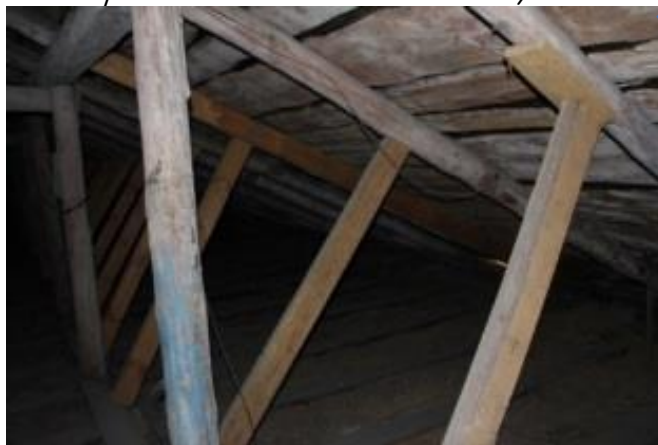
Фото 41. Устройство противоаварийных укосин под стропила в осях 2-8/Г-Ж
