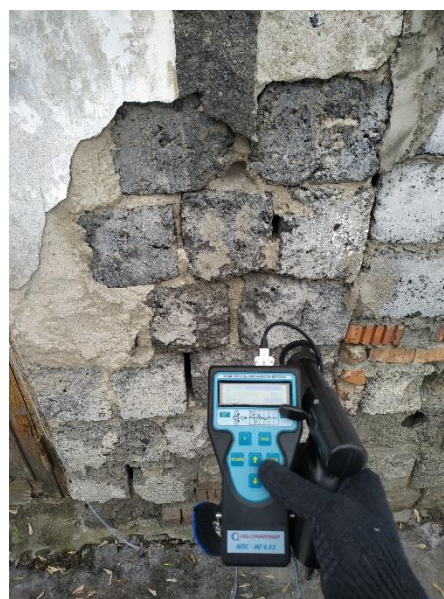
Фото 60. Определение прочности блоков кладки стен
