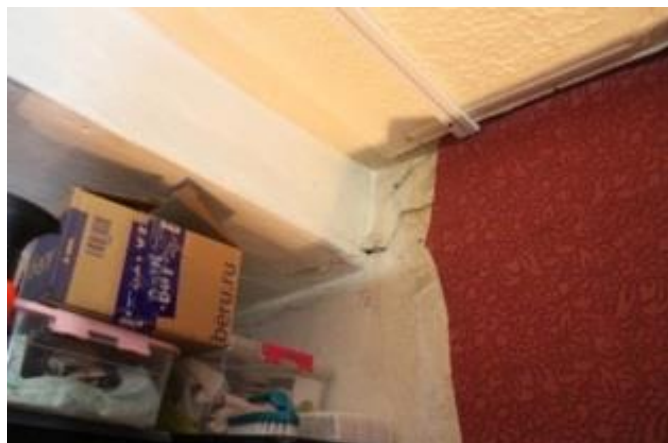
Фото 26. Трещина в колонне. По оси Д, 2-й этаж
