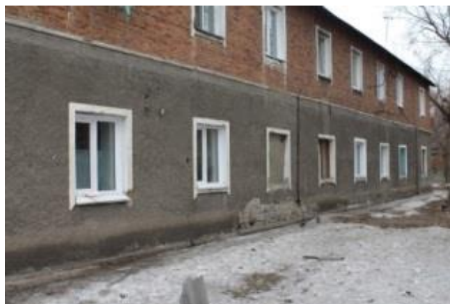
Фото 46. Фасад по оси Ж.
