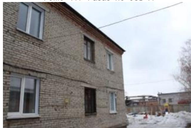
Фото 49. Фасад по оси А.
