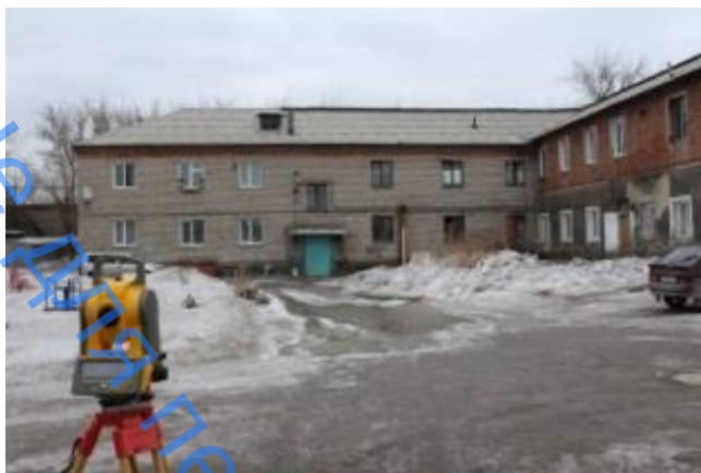
Фото 43. Контрольная съемка кренов стен тахеометром
