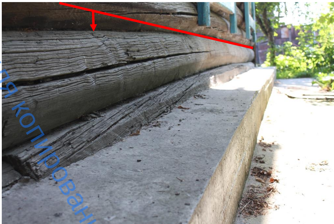
Фото 29. Отклонение горизонтальных линий стены от плоскости по оси 1
