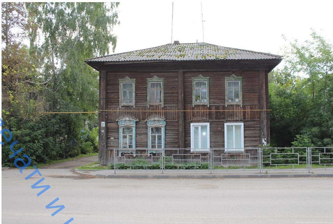
Фото 11. Фасад по оси В
