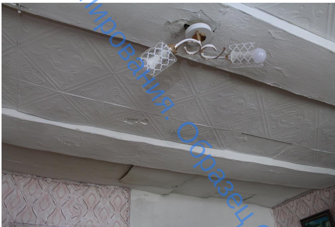
Фото 6. Перекрытие первого этажа в осях Б-В/2-3
