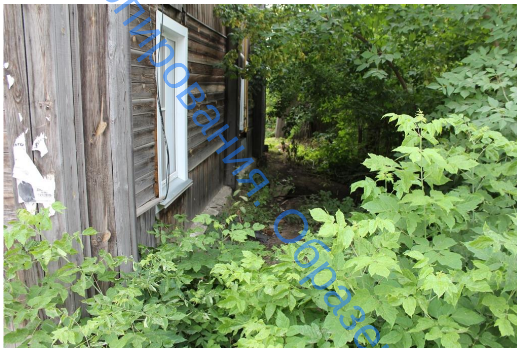
Фото 14. Отмостка, фасад по оси 1
