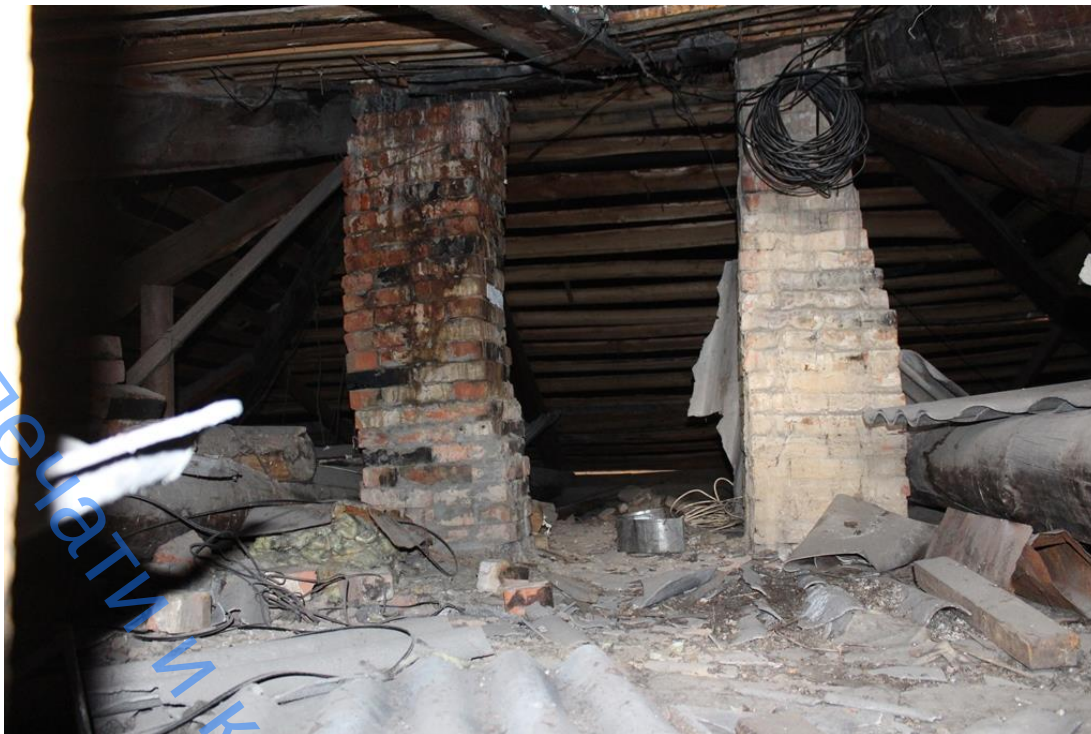
Фото 19. Искривление дымоходов
