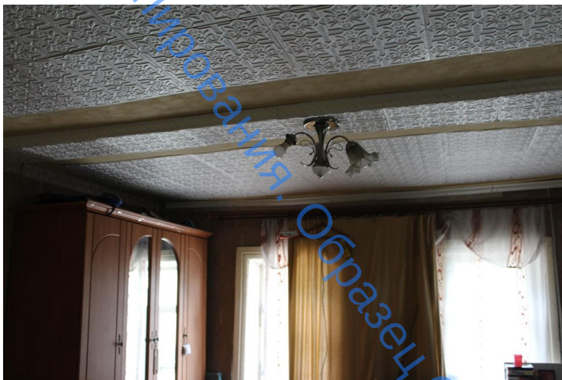
Фото 8. Перекрытие второго этажа в осях Б-В/2-3
