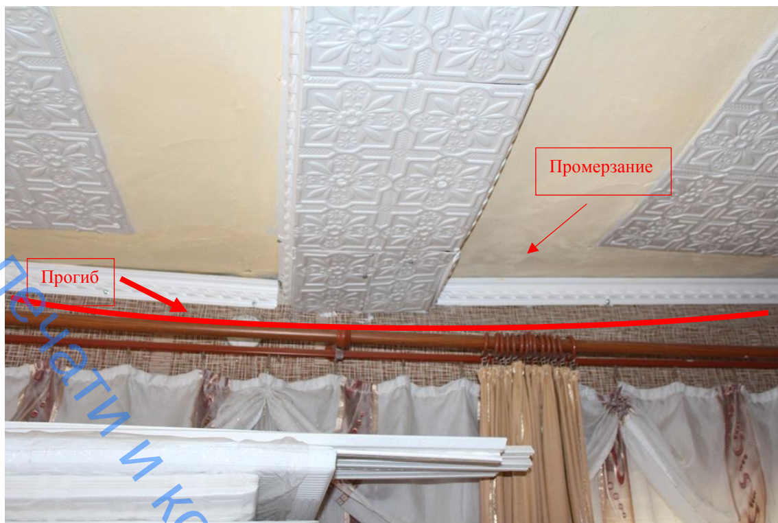
Фото 9. Перекрытие второго этажа в осях Б-В/2-3
