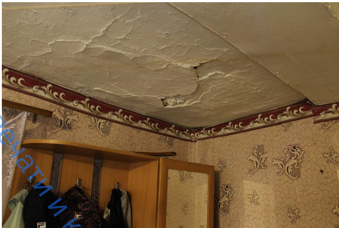
Фото 5. Перекрытие первого этажа в осях А-Б/2-3
