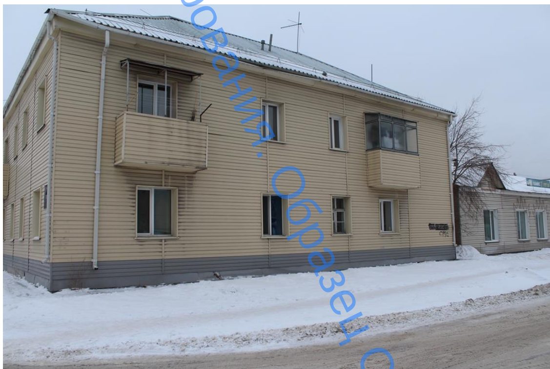
Фото 2. Фасад по оси 9
