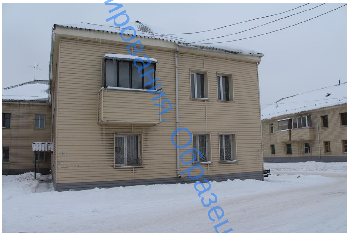
Фото 4. Фасад по оси 1
