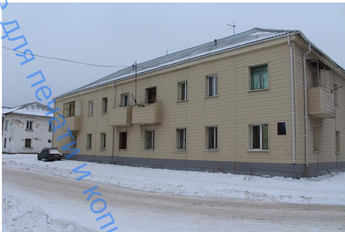
Фото 1. Фасад по оси А
