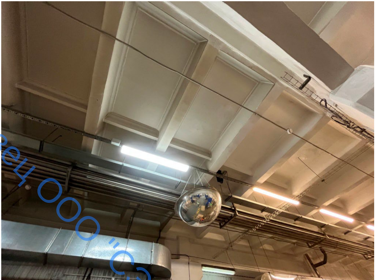
Фото 23. Конструкции перекрытия 1-го этажа в осях 1-2/Б-Г. Общий вид
