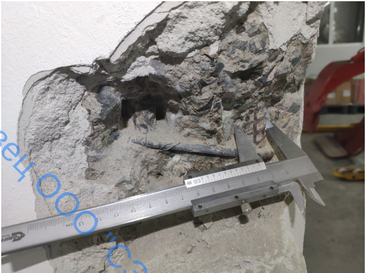
Фото 25. Контрольное вскрытие системы рабочего армирования колонн каркаса К4 в осях 4/В
