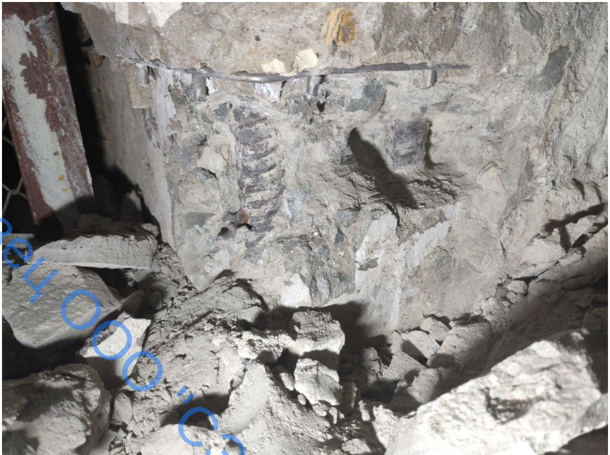
Фото 35. Контрольное вскрытие системы рабочего армирования колонн каркаса К1 в осях 2/В
