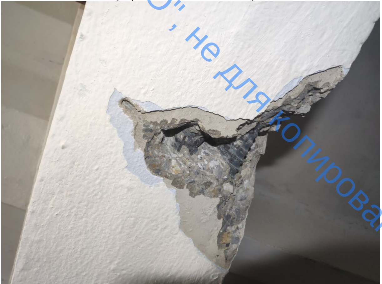
Фото 32. Контрольное вскрытие системы рабочего армирования ригеля каркаса Р1 перекрытия 2-го этажа в осях 2/Б-В
