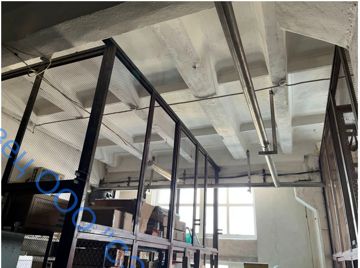
Фото 5. Конструкции перекрытия 2-го этажа в осях 1-2/Б-В. Общий вид
