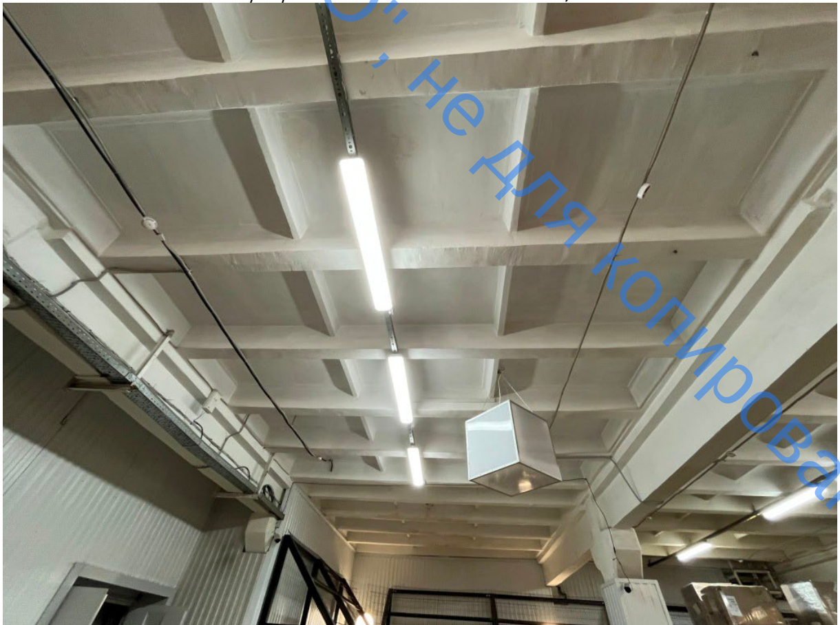
Фото 18. Конструкции перекрытия 1-го этажа в осях 5-6/Б-Г. Общий вид
