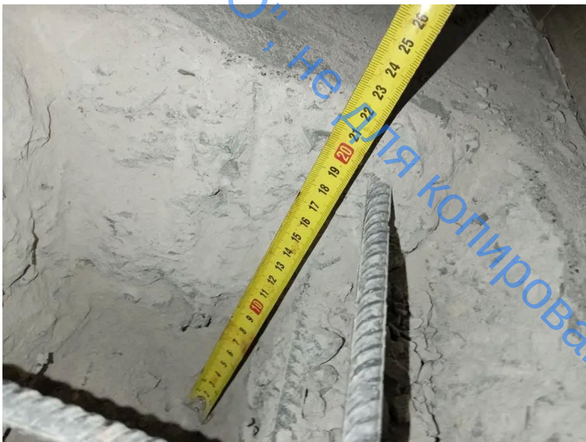
Фото 40. Контрольное вскрытие конструкций пола 2-го этажа в осях 3-6/Б-Г
