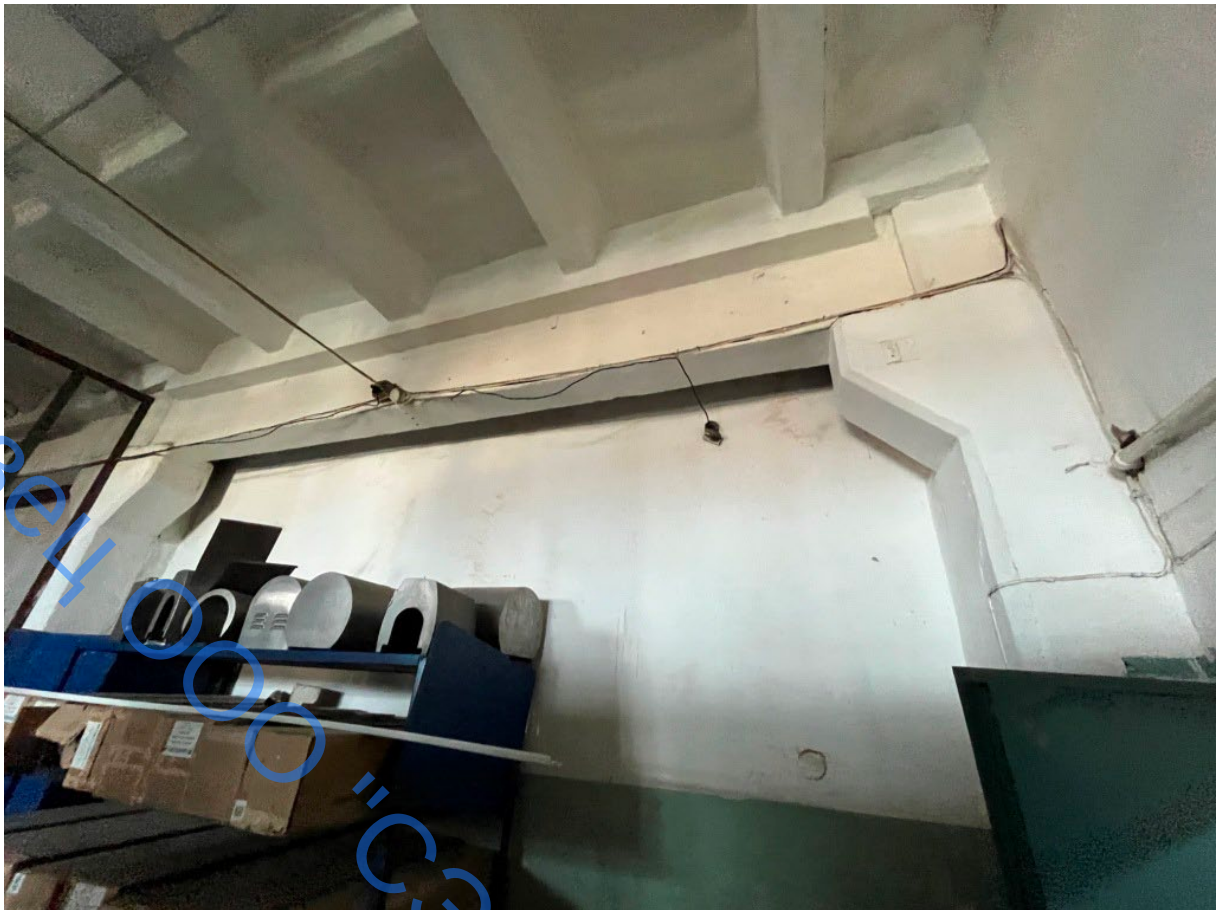
Фото 3. Опираение плит перекрытие 2-го этажа на ригели каркаса в осях Б-В/3. Общий вид
