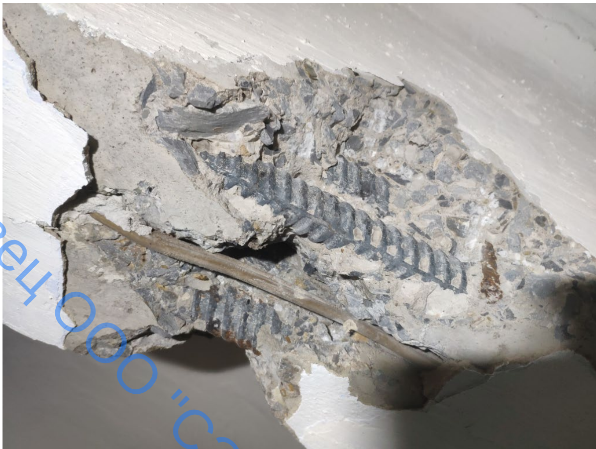
Фото 27. Контрольное вскрытие системы рабочего армирования плит П2 и П4 перекрытия 2-го этажа в осях 2-3/Б-В
