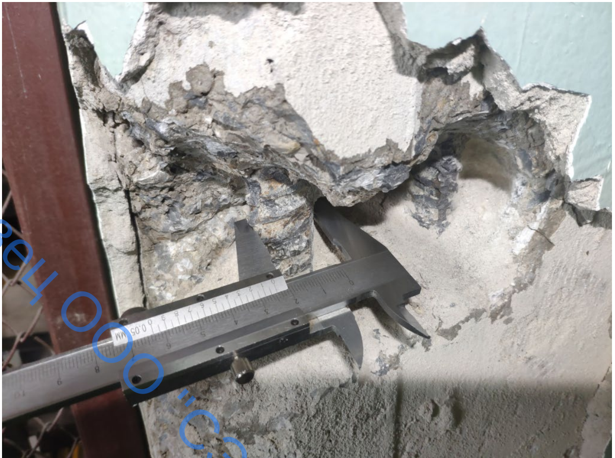
Фото 37. Контрольное вскрытие системы рабочего армирования колонн каркаса КЗ в осях 2/В
