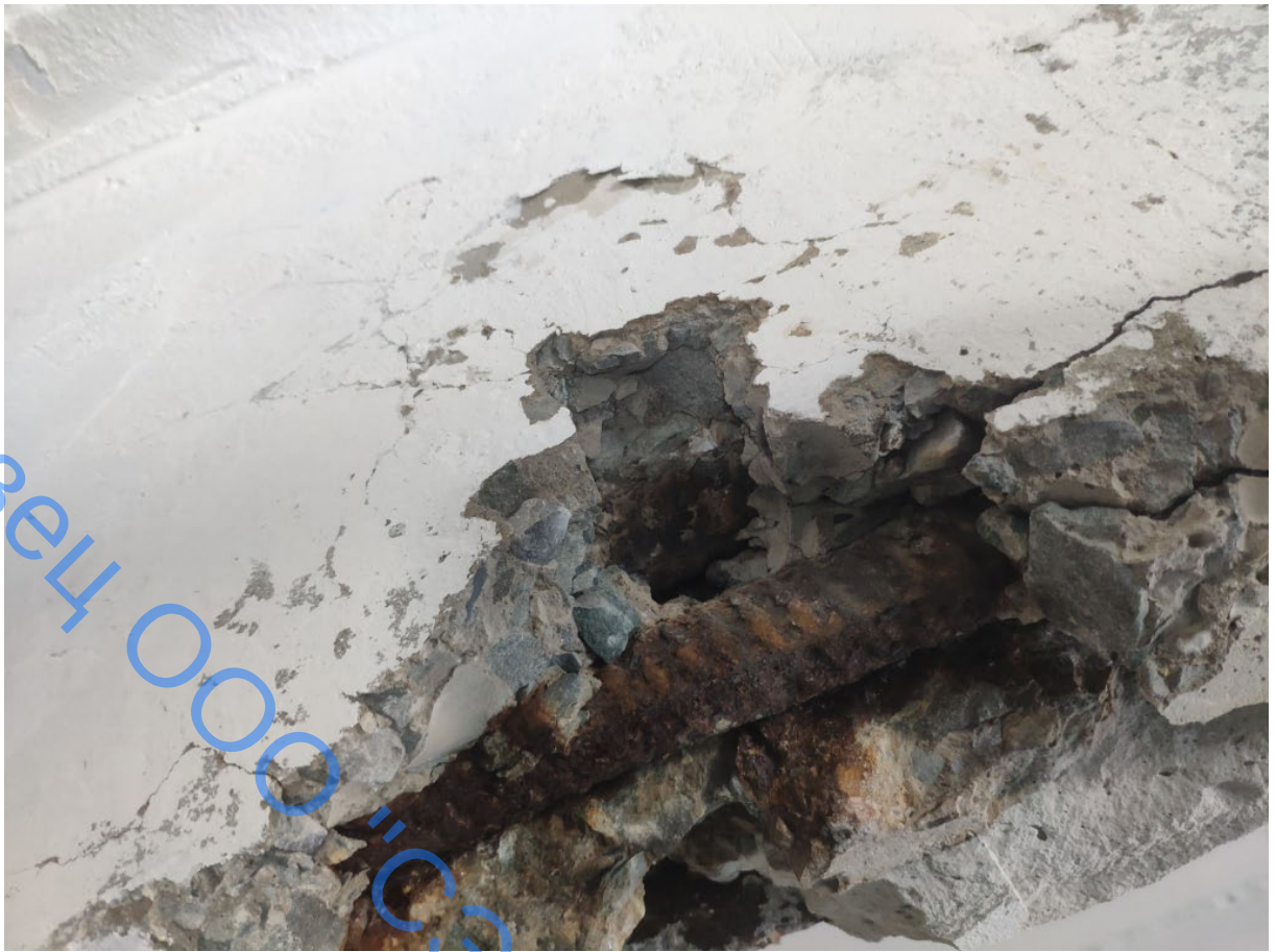
Фото 29. Контрольное вскрытие системы рабочего армирования плиты П1 перекрытия 2-го этажа в осях 1-2/Б-В
