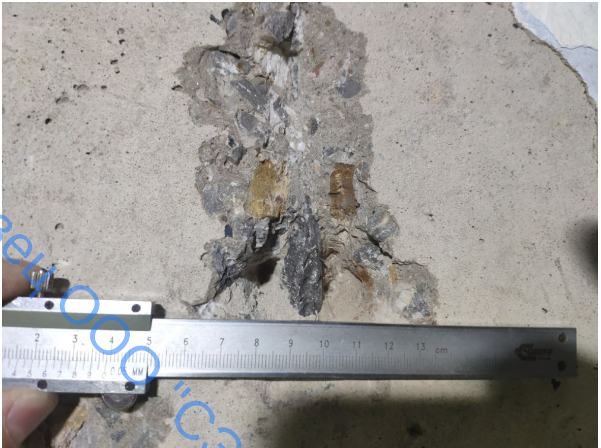
Фото 31. Контрольное вскрытие системы поперечного армирования ригеля каркаса Р1 перекрытия 2-го этажа в осях 2/Б-В
