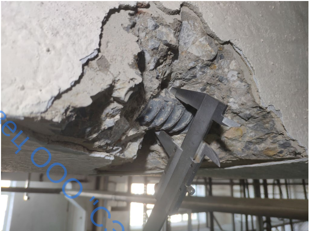
Фото 33. Контрольное вскрытие системы рабочего армирования ригеля каркаса Р1 перекрытия 2-го этажа в осях 2/Б-В
