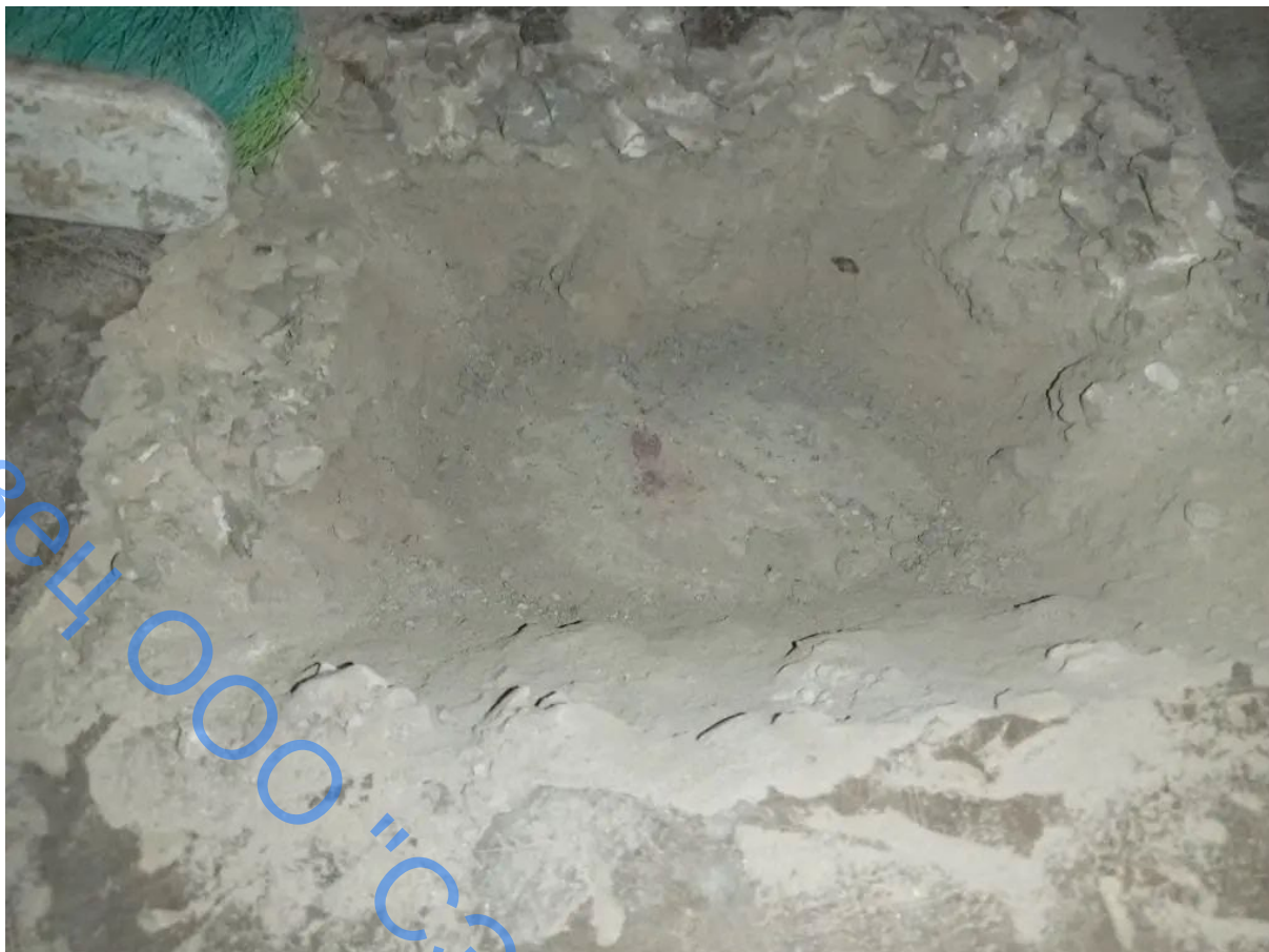
Фото 39. Контрольное вскрытие конструкций пола 2-го этажа в осях 1-3/Б-Г
