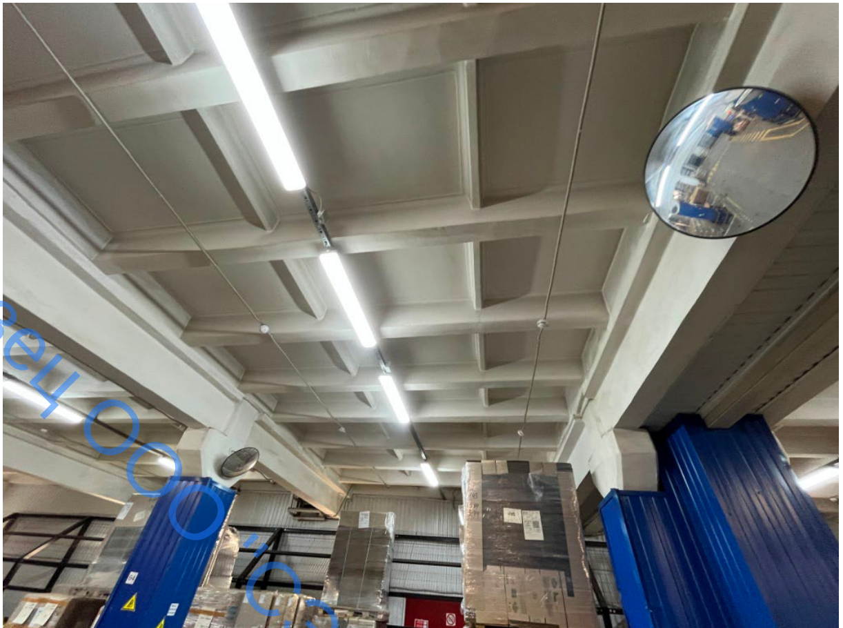
Фото 21. Конструкции перекрытия 1-го этажа в осях 3-4/Б-Г. Общий вид
