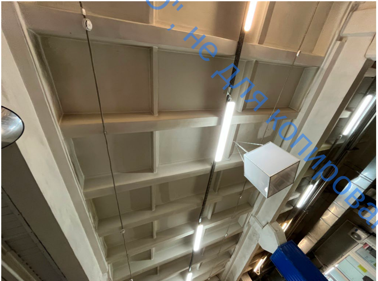
Фото 22. Конструкции перекрытия 1-го этажа в осях 2-3/Б-Г. Общий вид
