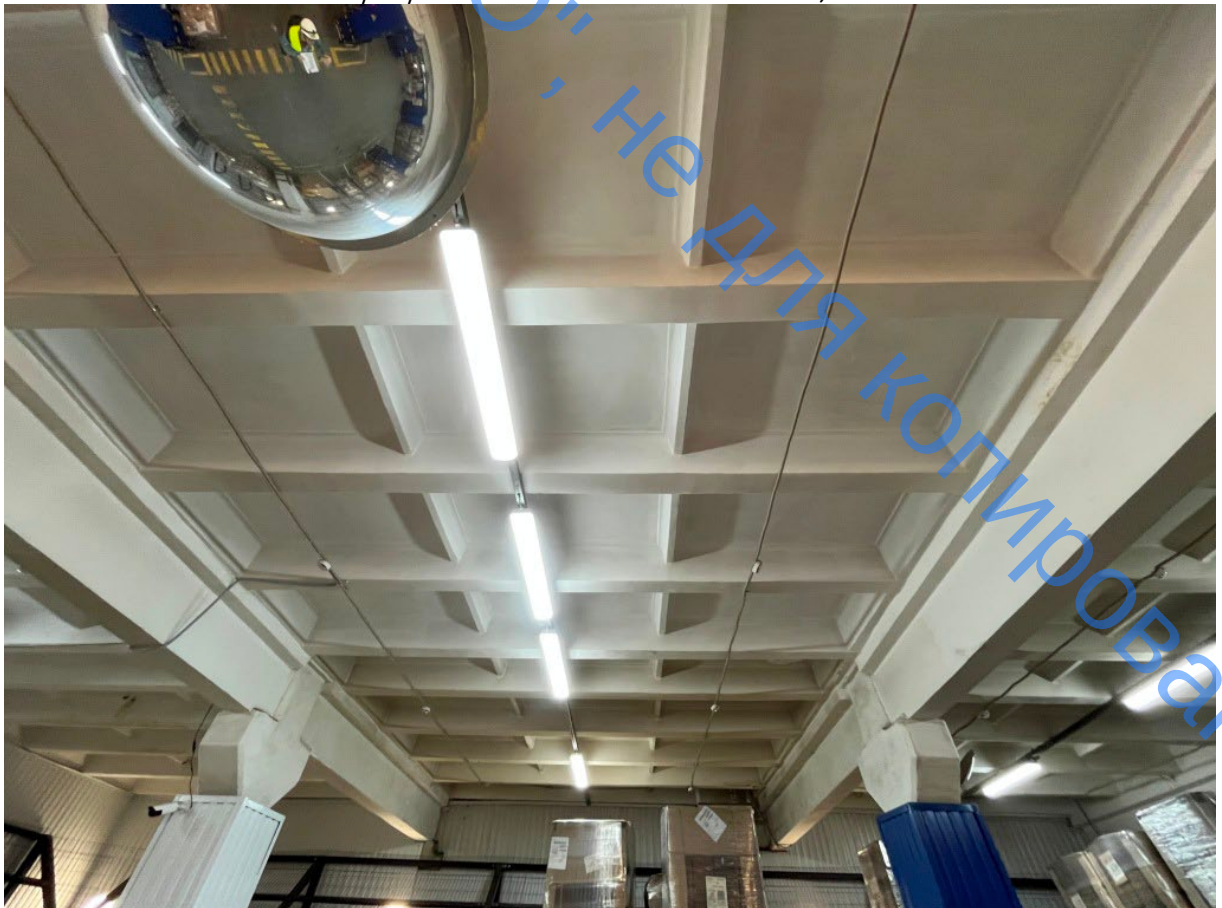
Фото 20. Конструкции перекрытия 1-го этажа в осях 4-5/Б-Г. Общий вид
