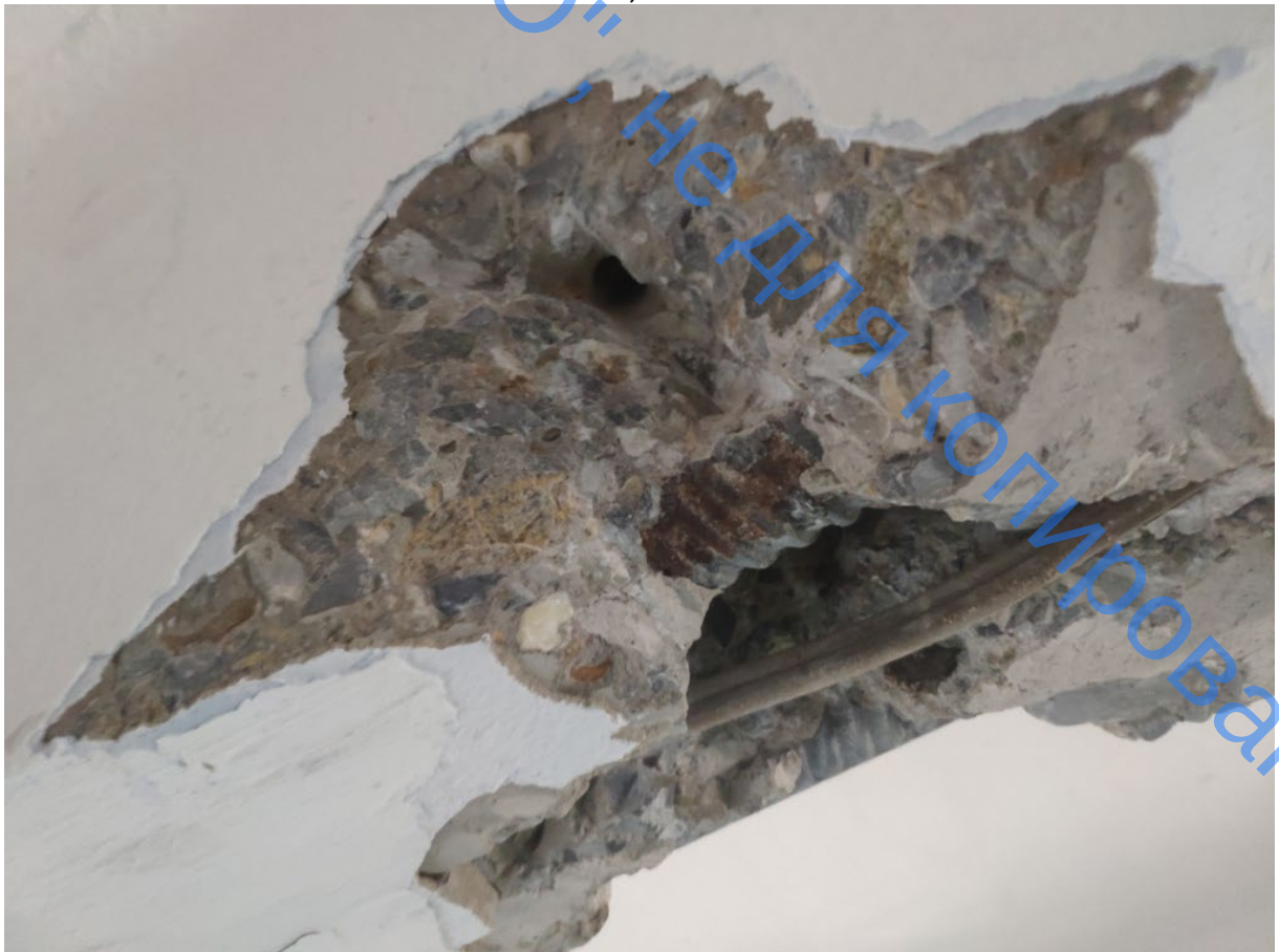
Фото 26. Контрольное вскрытие системы рабочего армирования плиты П4 перекрытия 2-го этажа в осях 2-3/Б-В
