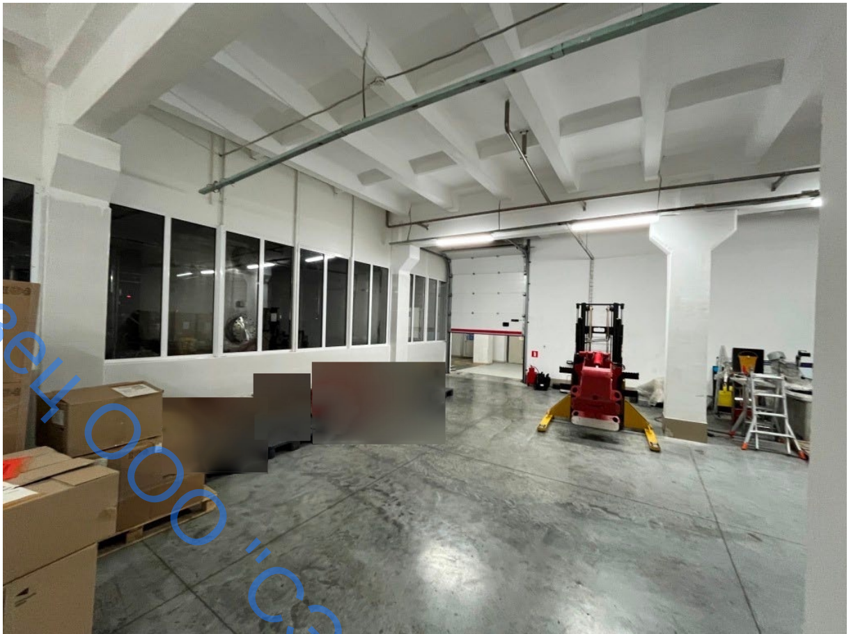
Фото 13. Помещение 2-го этажа в осях 3-б/Б-Г. Общий вид
