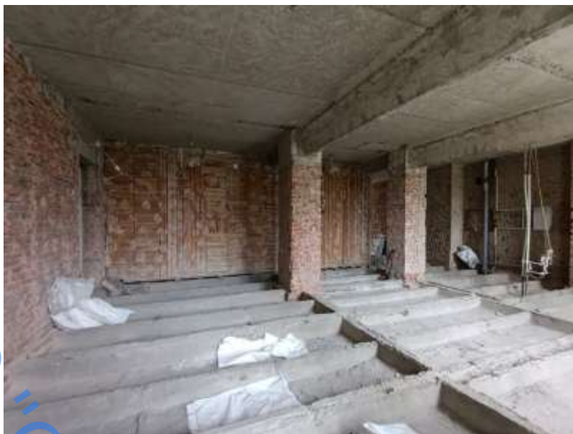
Фото 1. Общий вид перекрытия
