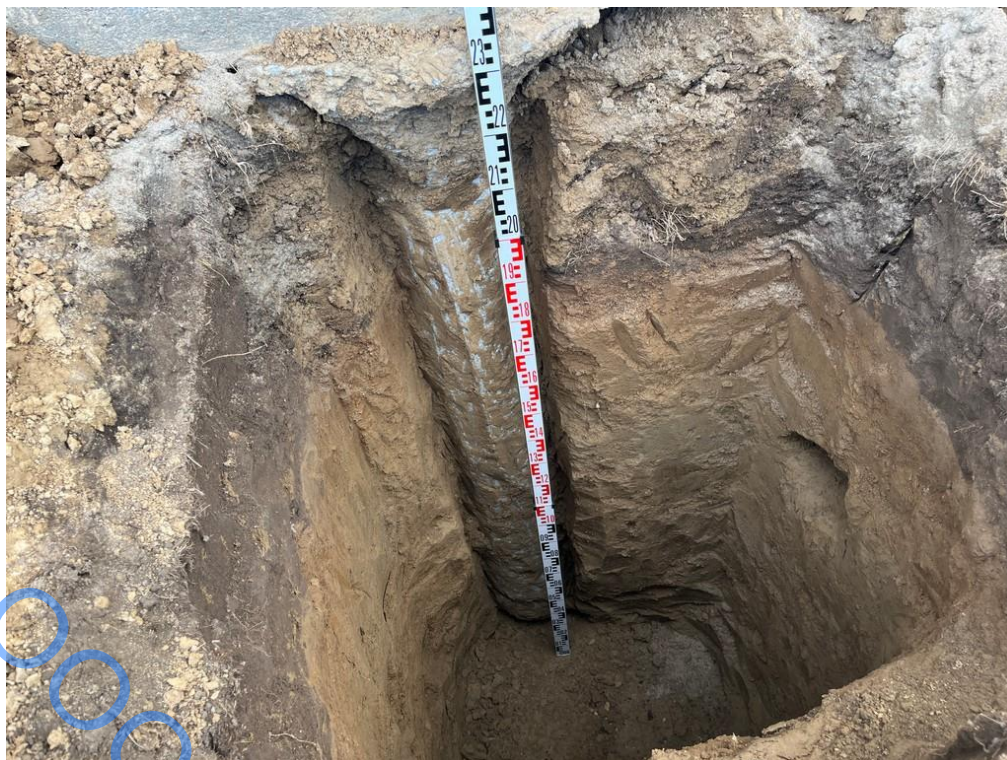
Фото №21 – Общий вид шурфа
