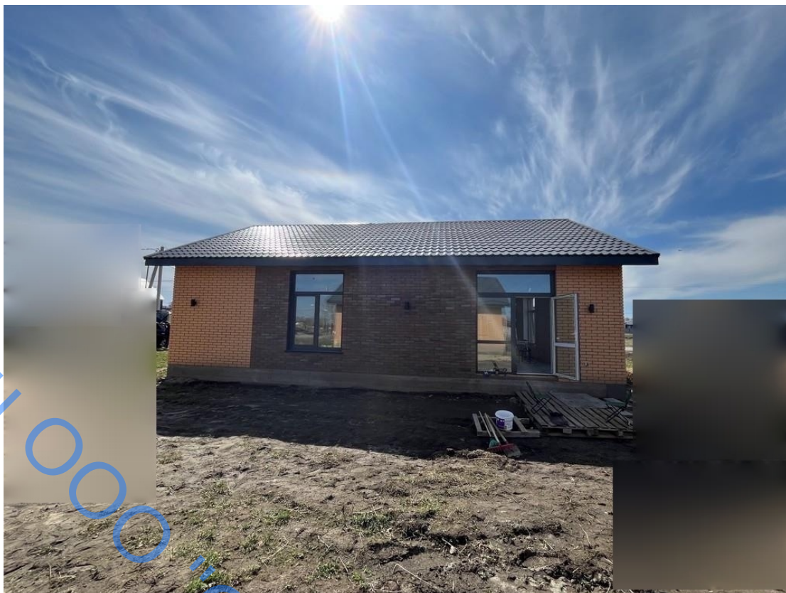
Фото №3 — Фасад здания по оси Б
